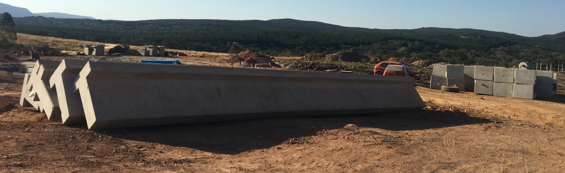
PONTE PRÉ-FABRICADA VIGAS E TABULEIRO
