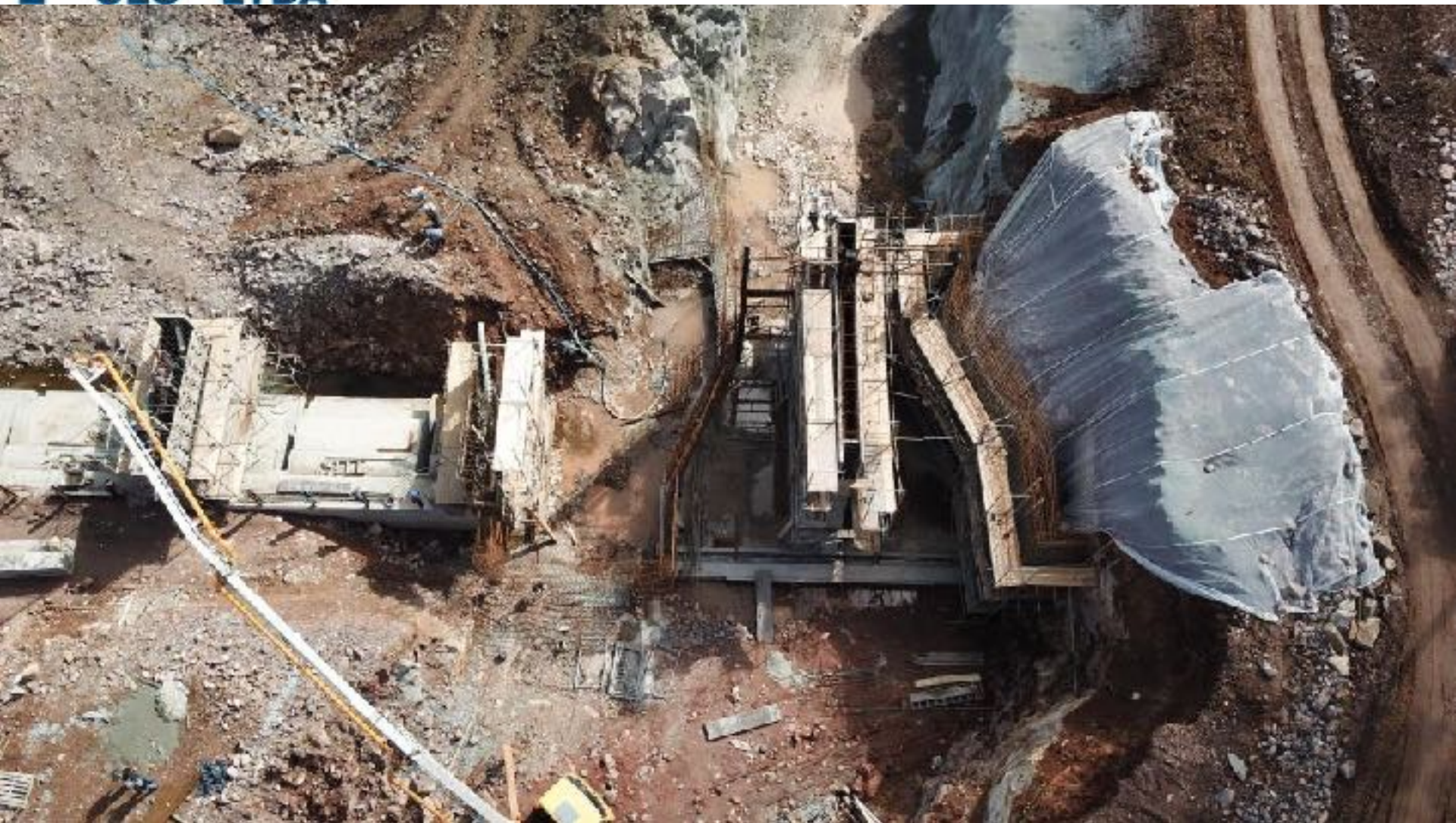
TOMADA D'ÁGUA ELEVAÇÃO DAS PAREDES
