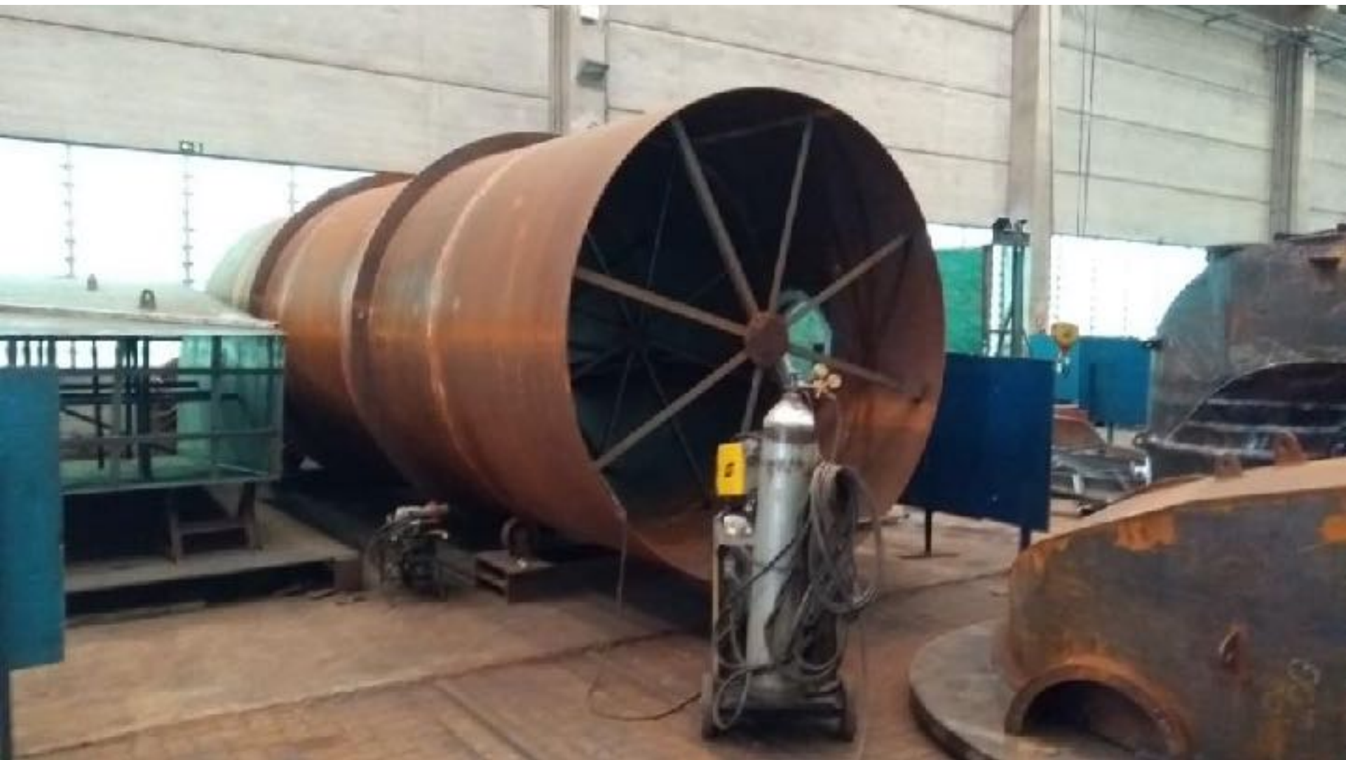
TURBINA TUBO DE ENTRADA EM FABRICAÇÃO
