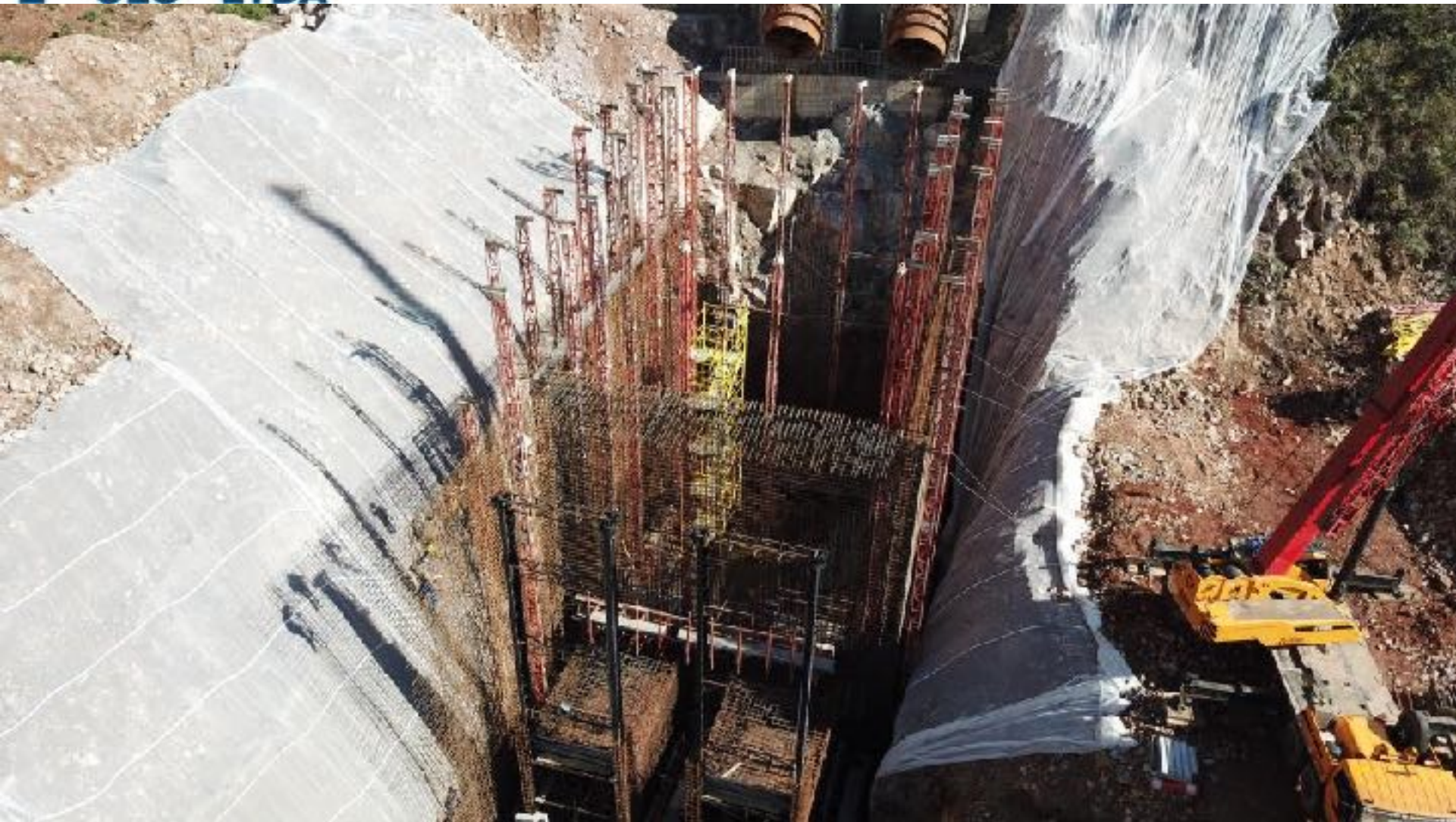
CASA DE FORÇA MONTAGEM DAS SUCÇÕES
