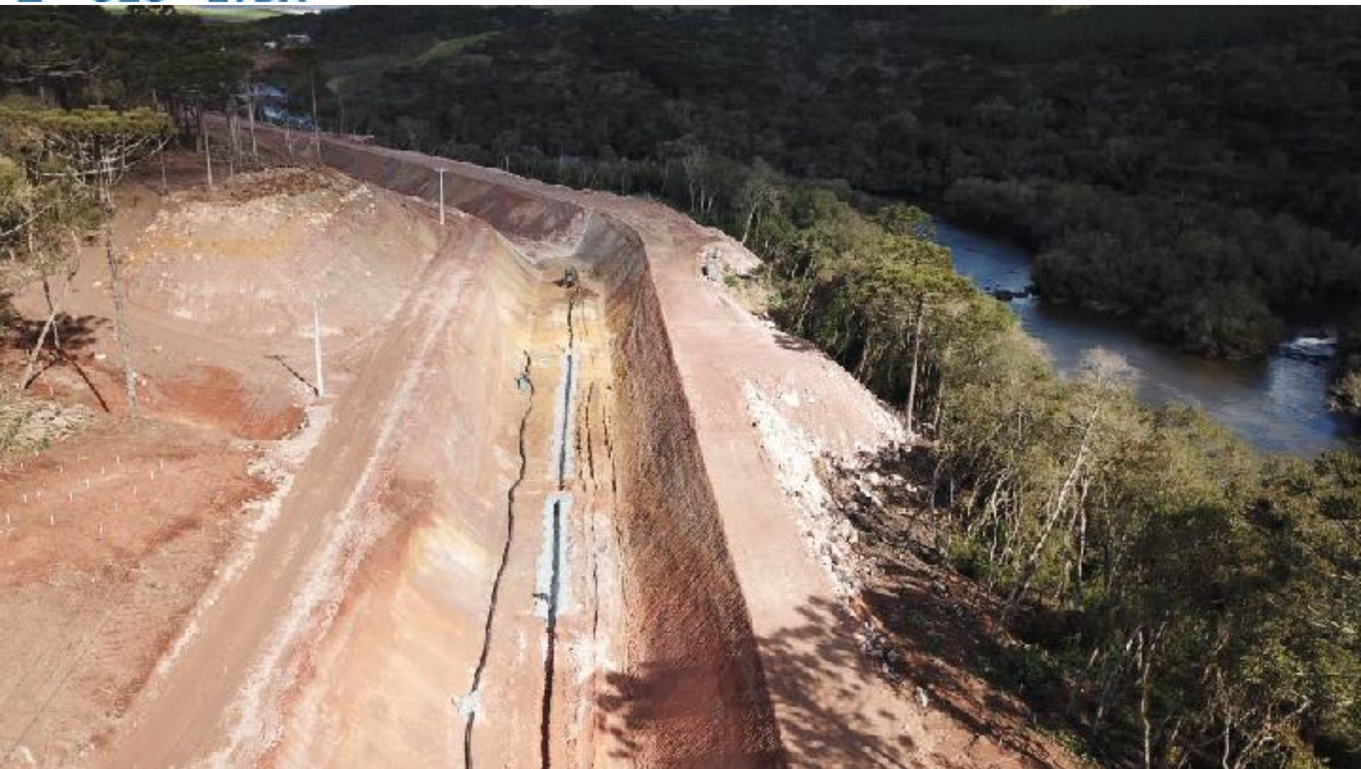
CANAL ADUTOR EXECUÇÃO DO DRENO DE FUNDO
