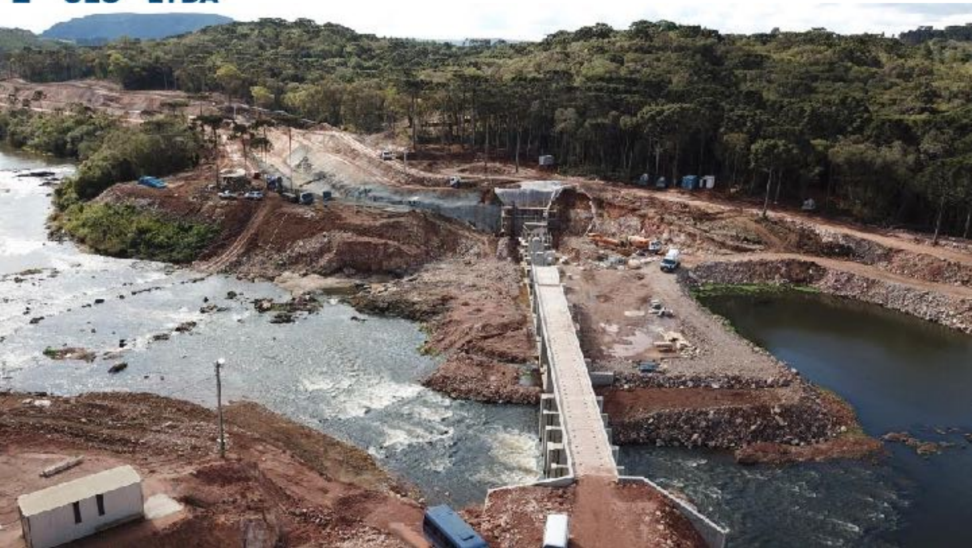
VISTA GERAL DO SETOR DA BARRAGEM E INICIO DO CANAL
