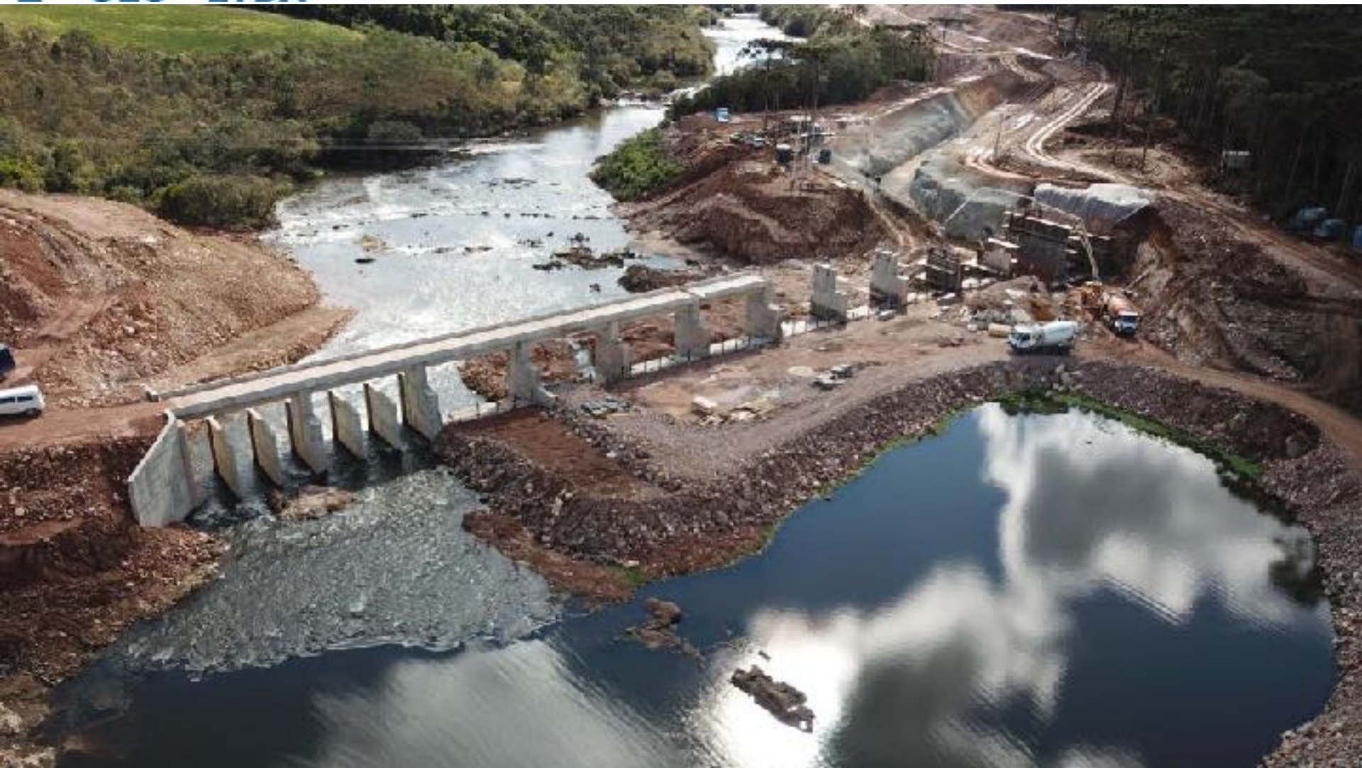
BARRAGEM VISTA DE MONTANTE AGOSTO
