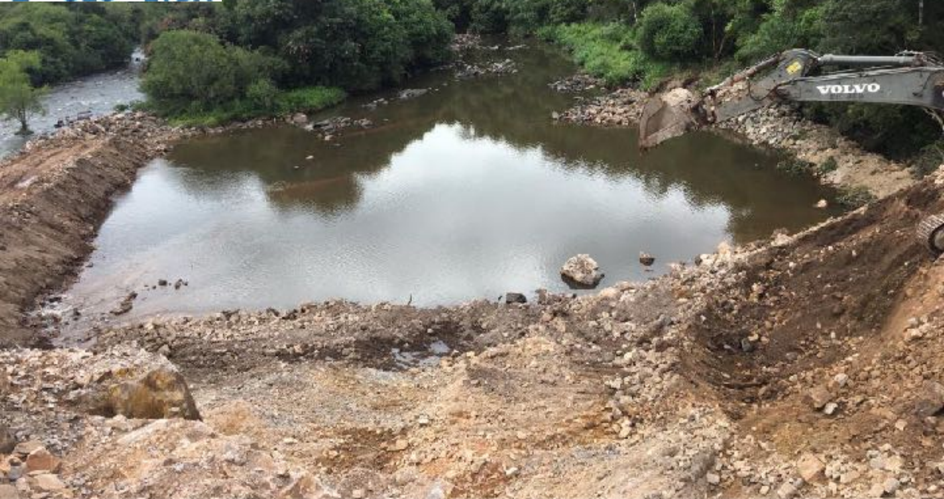
CASA DE FORÇA ROCHA EXPOSTA E ENSECADEIRA DO CANAL DE FUGA EM EXECUÇÃO
