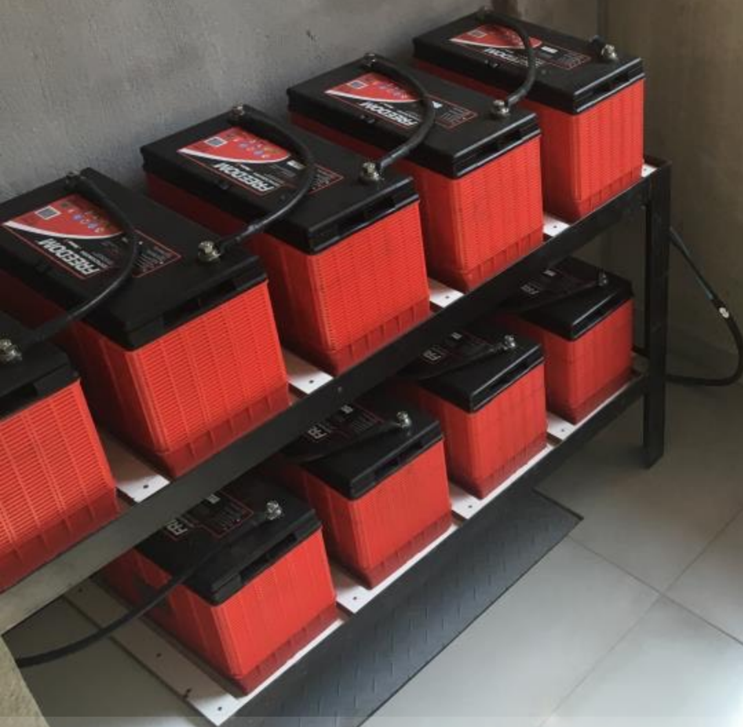
SALA DE COMANDO BANCO DE BATERIAS MONTADO
