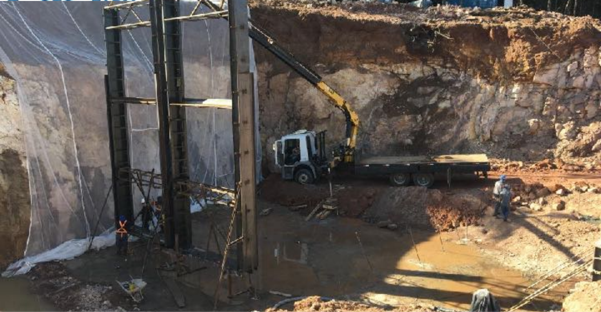
TOMADA D'ÁGUA MONTAGEM DAS GUIAS DAS COMPORTAS
