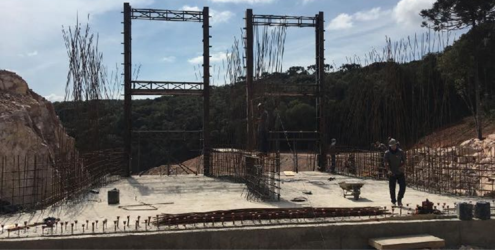
CÂMARA DE CARGA VISTA ABRIL
