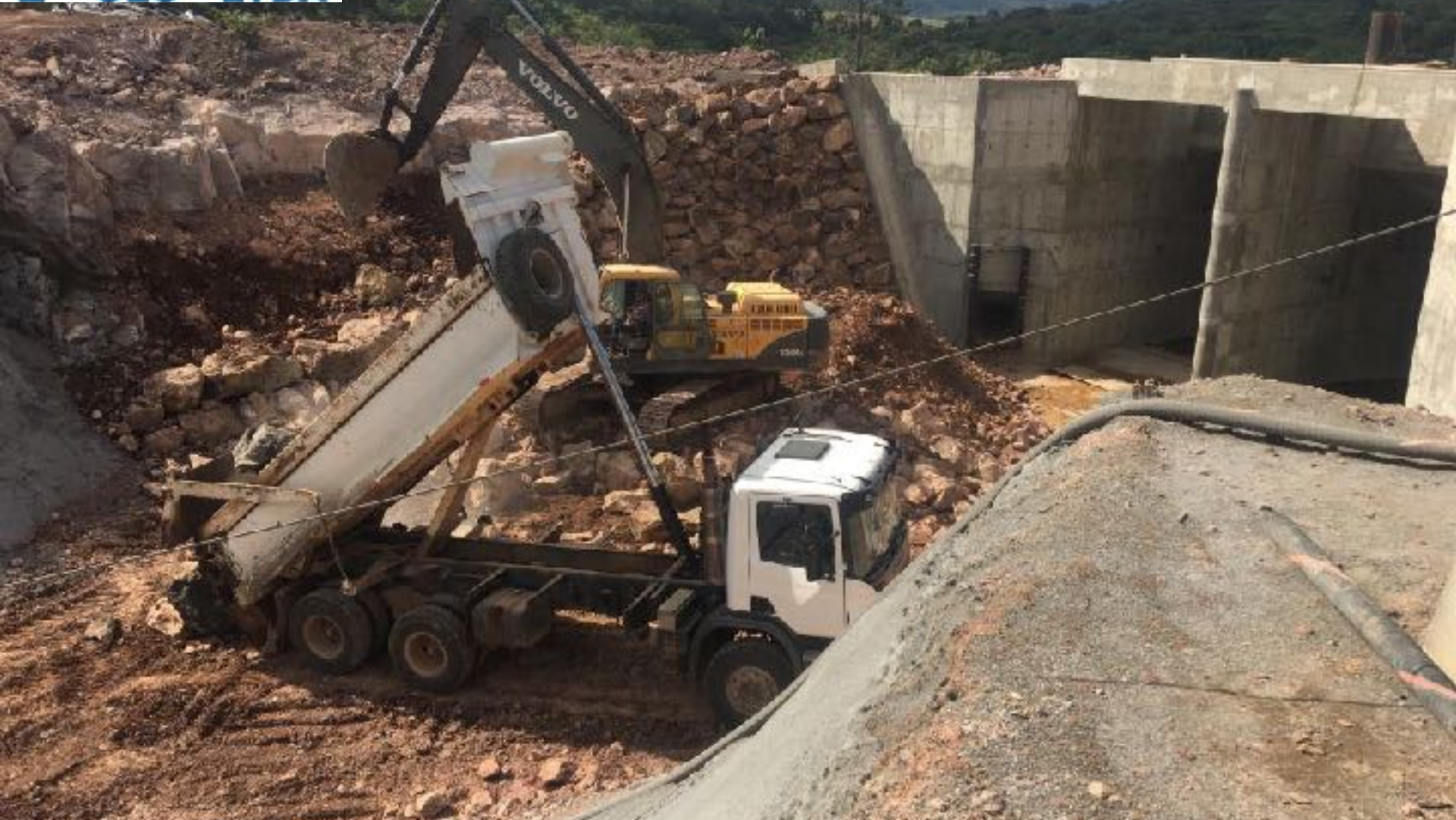
CANAL ADUTOR RECOMPOSIÇÃO DA TRANSIÇÃO CANAL/CÂMARA DE CARGA COM PEDRAS MONTADAS EM SEGUIDA CONCRETO PROJETADO
