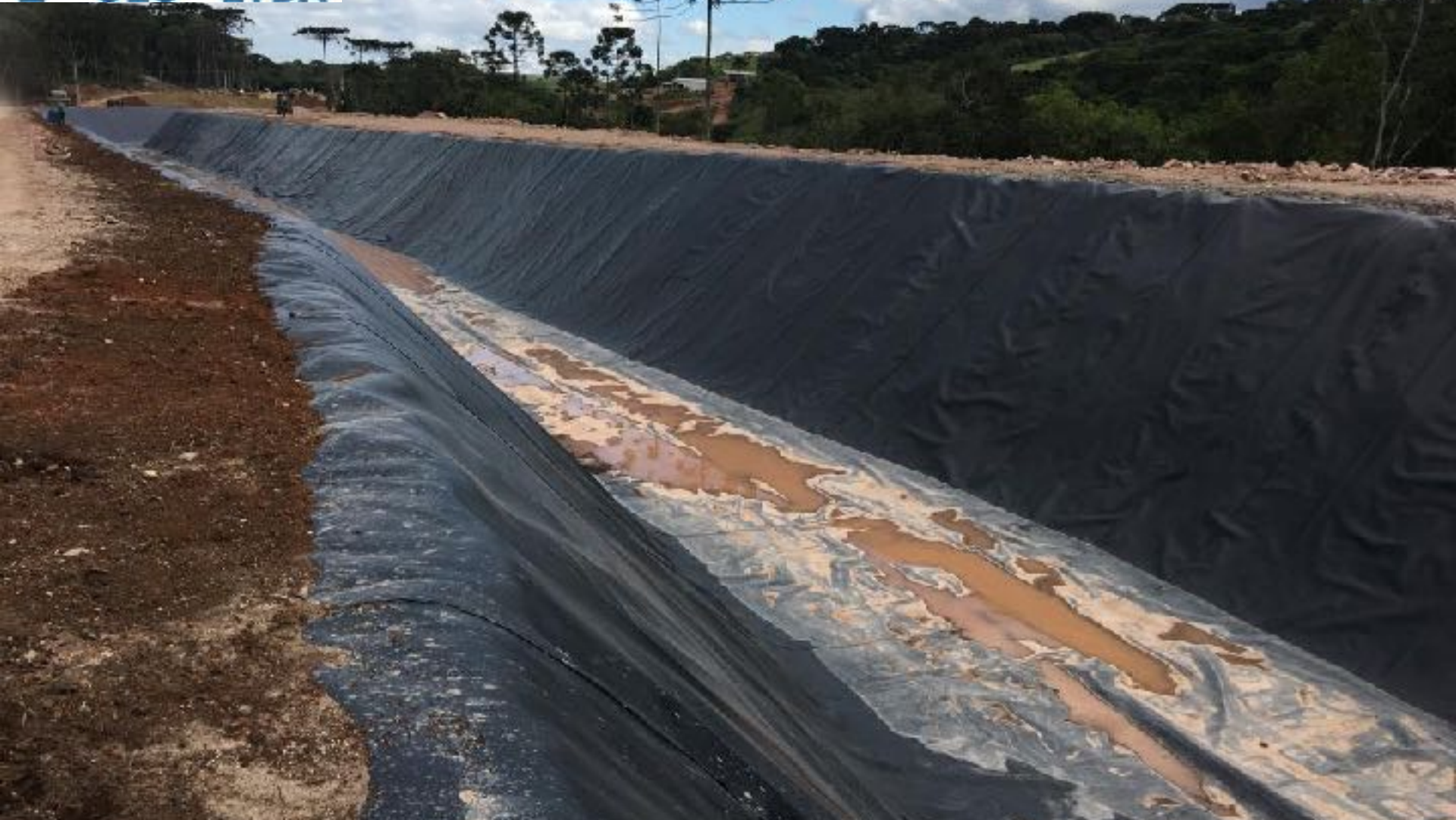
CANAL ADUTOR VALAS REATERRADAS E SENDO PLANTADO GRAMÍNEAS
