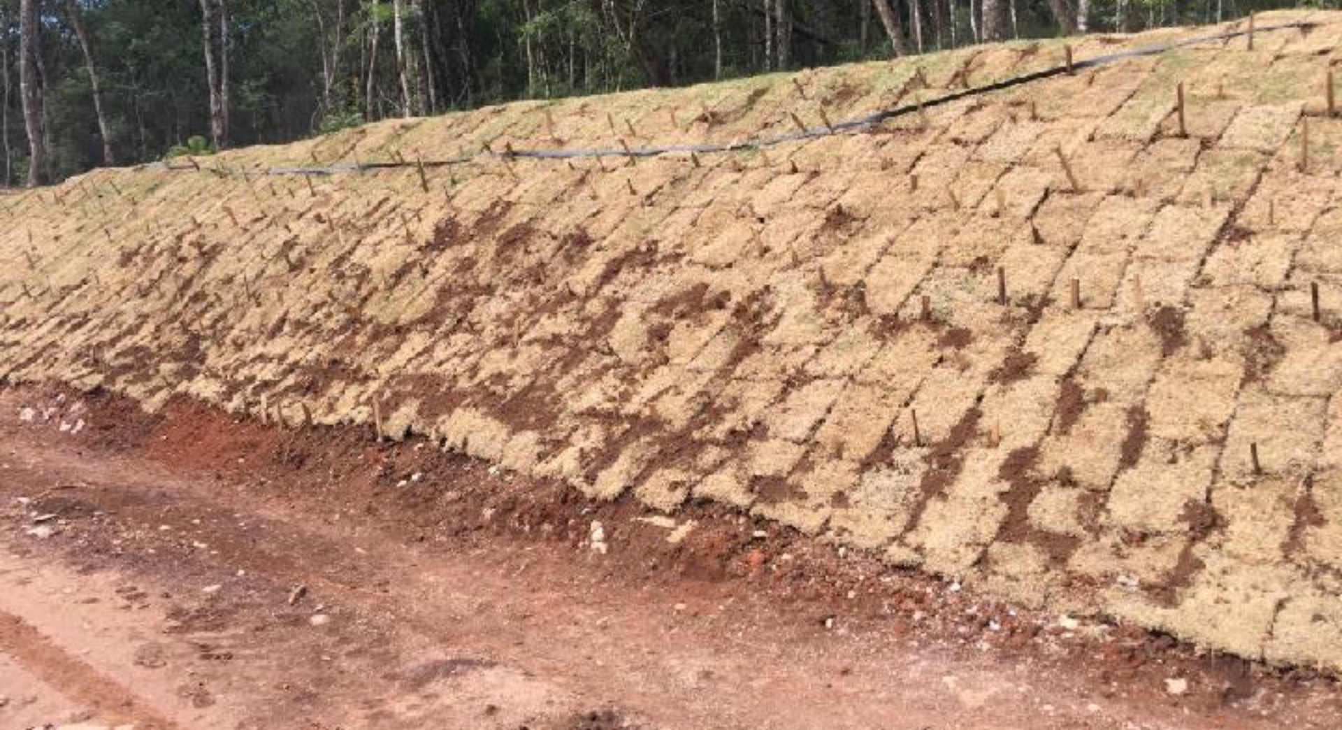
CANAL ADUTOR RECOMPOSIÇÃO DE TALUDES
