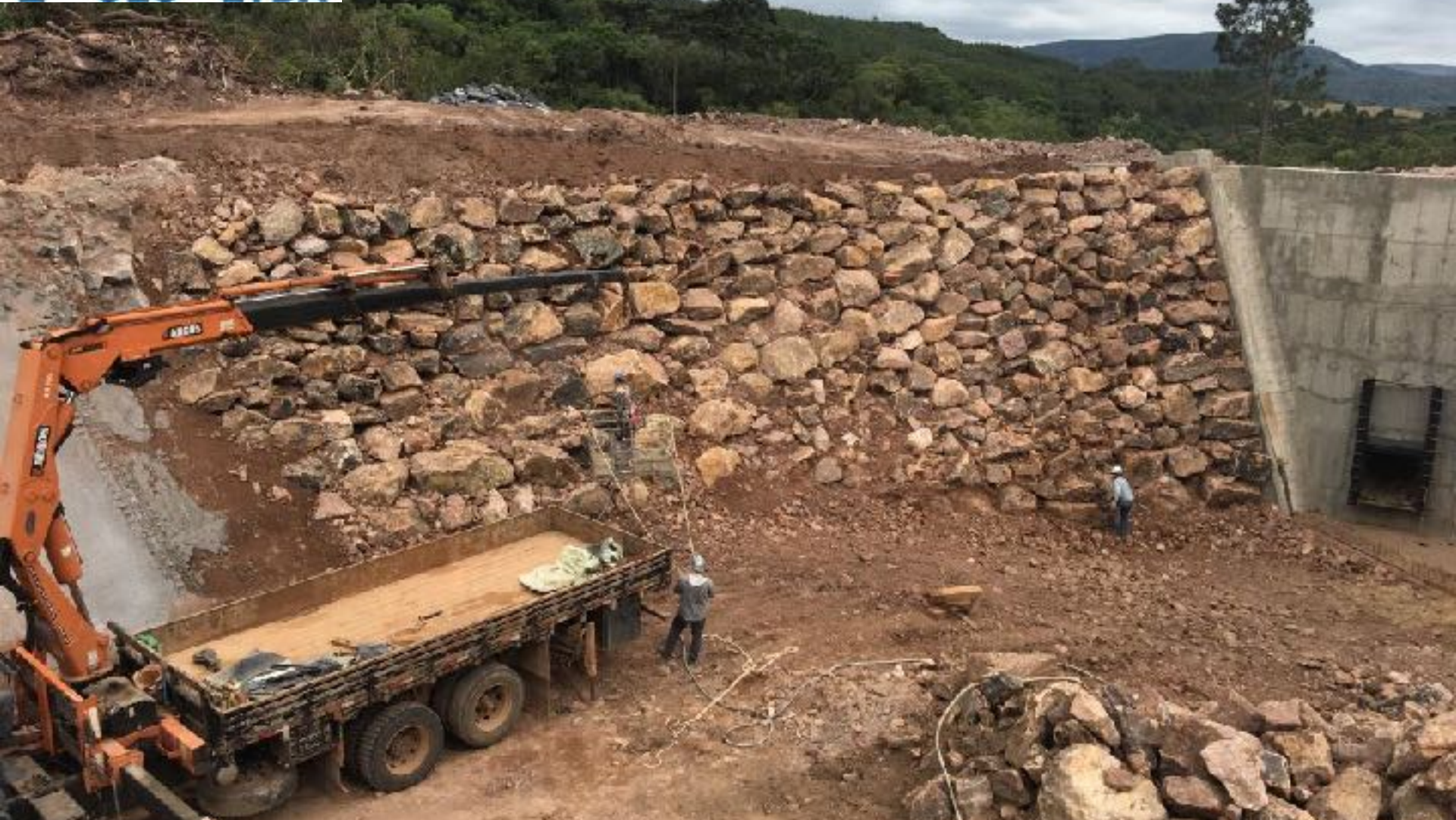
CANAL ADUTOR RECOMPOSIÇÃO DA TRANSIÇÃO ANTES DO INÍCIO DO CONCRETO PROJETADO
