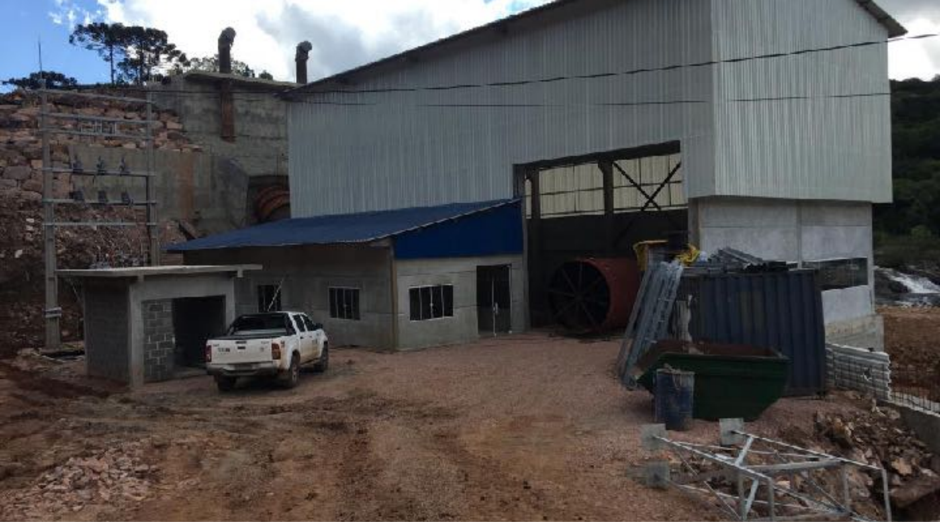
CASA DE FORÇA/SALA DE COMANDO/SE ELEVADORA VISTA GERAL
