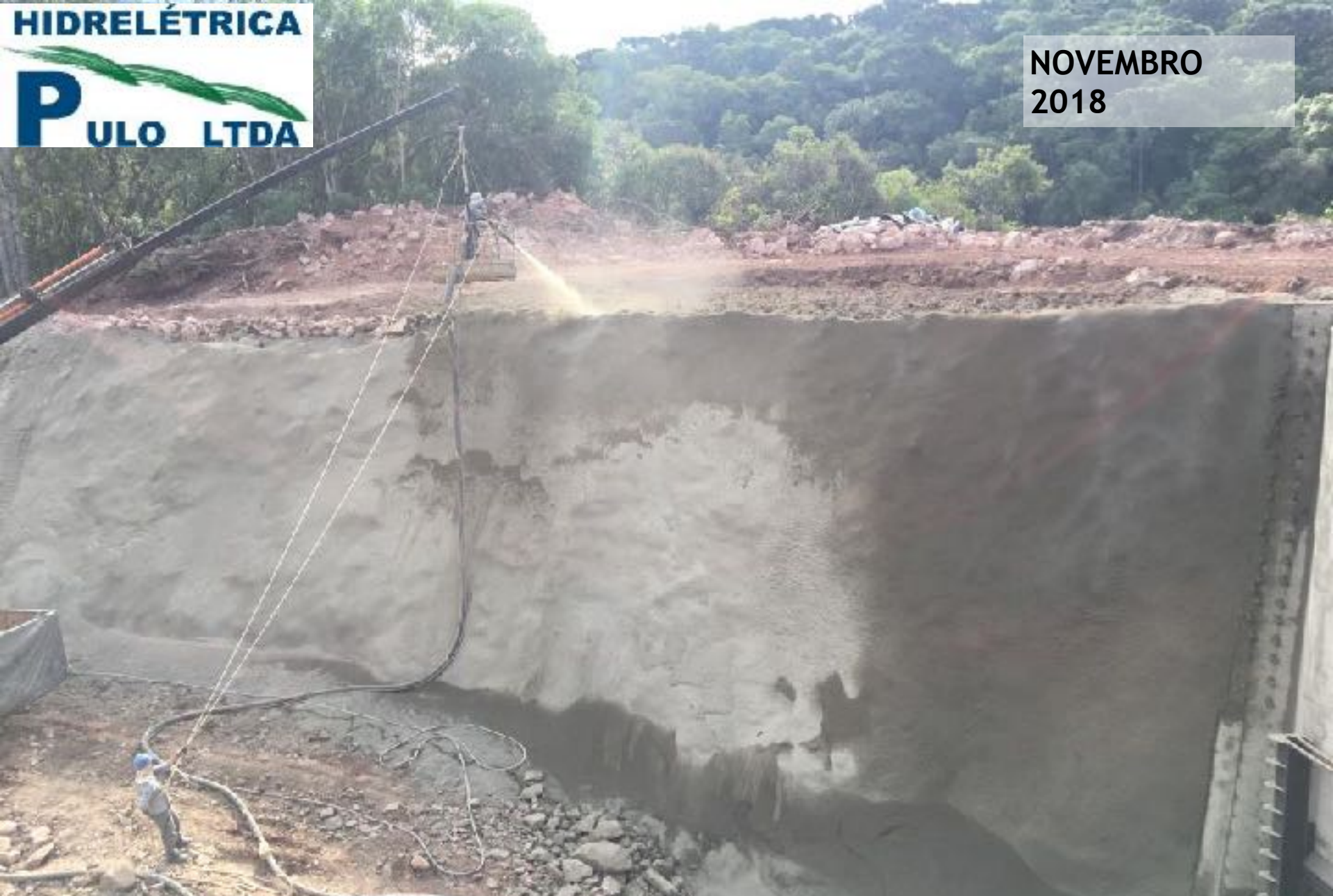
▶ CANAL ADUTOR APLICAÇÃO DO CONCRETO PROJETADO
