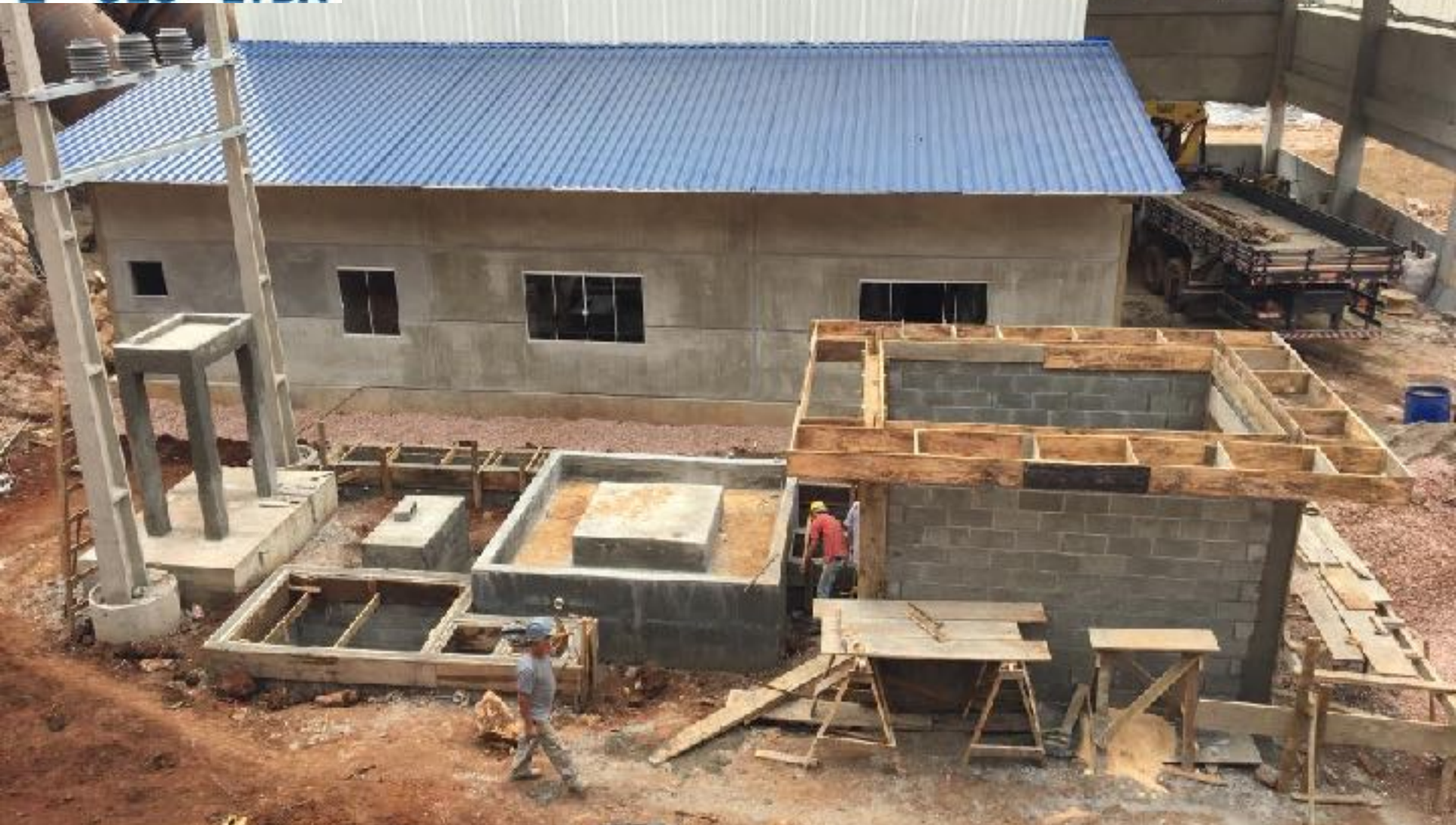
SUBESTAÇÃO ELEVADORA CONSTRUÇÃO CIVIL DAS BASES E ABRIGO DO GRUPO DIESEL
