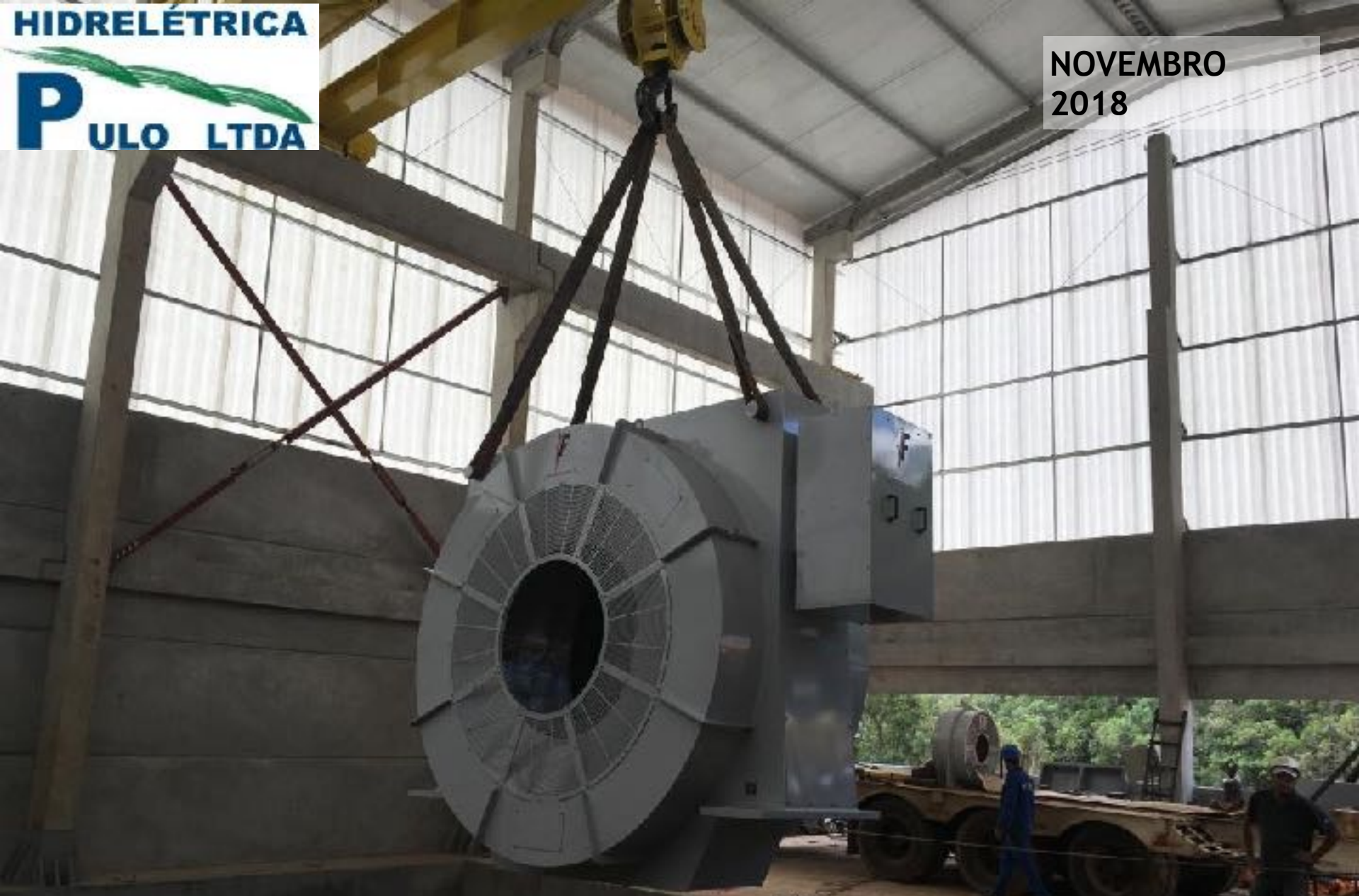
CASA DE FORÇA MONTAGEM DO GERADOR 1 INICIADA
