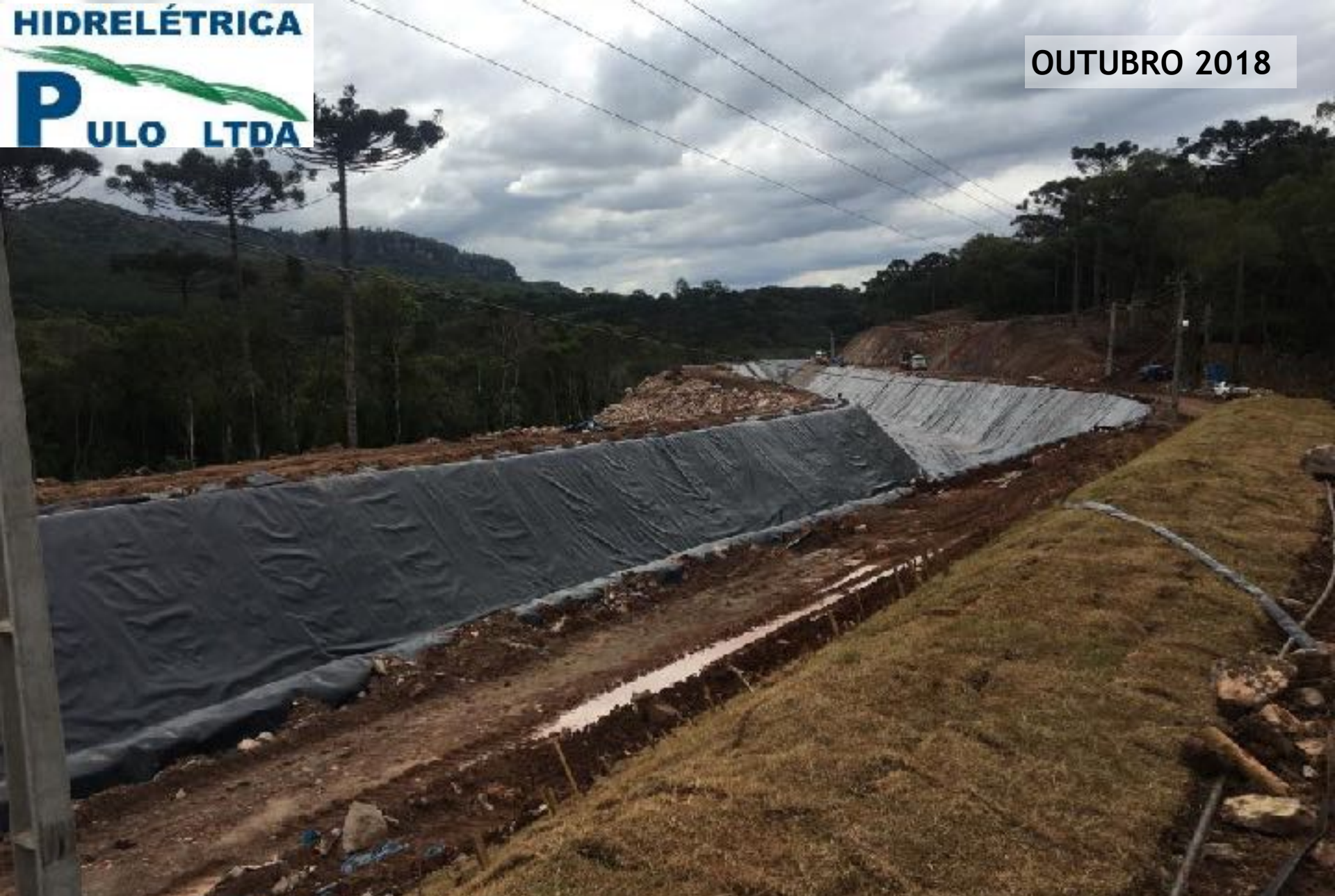
CANAL ADUTOR VISTA DO CANAL SENDO REVESTIDO
