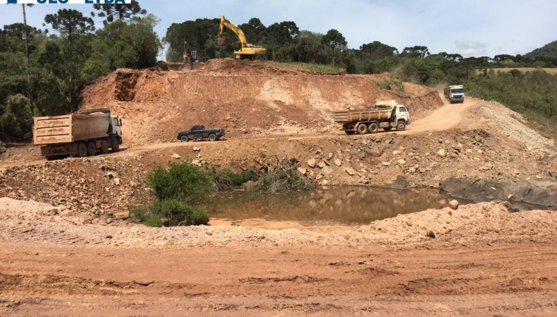
BARRAGEM ESCAVAÇÕES NA OMBREIRA ESQUERDA
