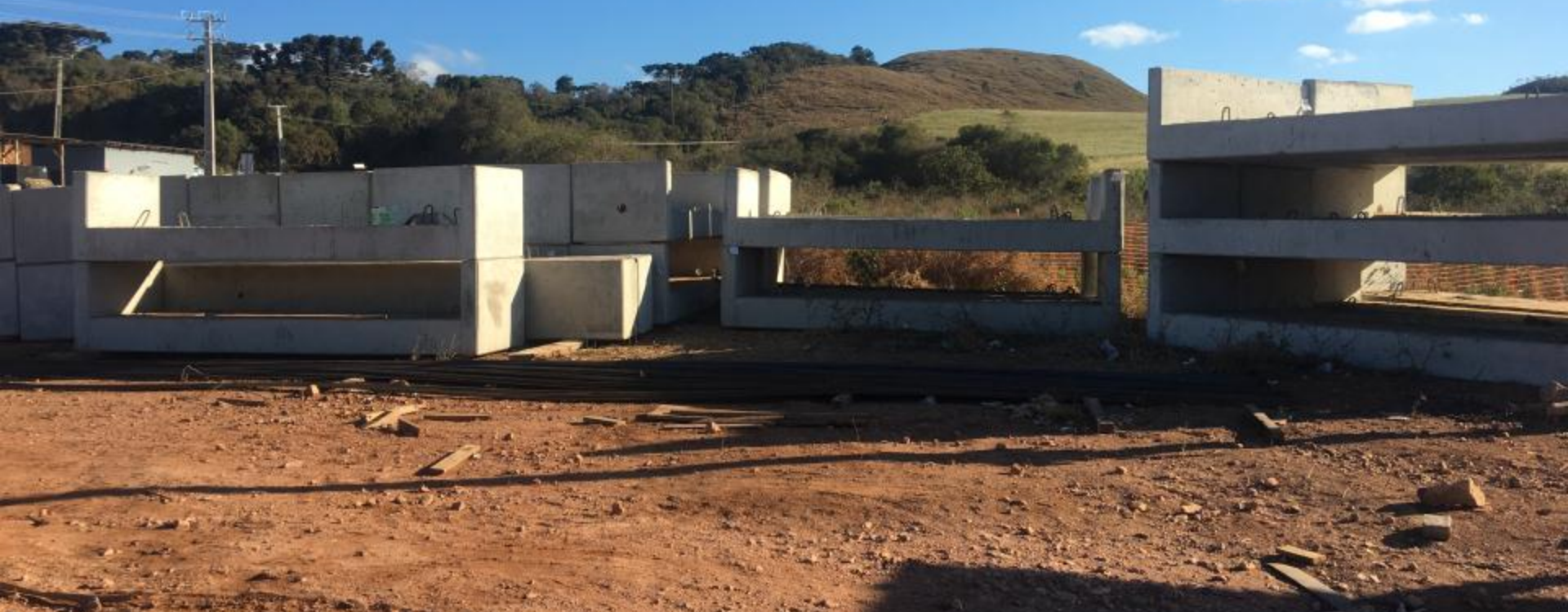
PONTE PRÉ-FABRICADA TABULEIRO DA PONTE – 90% ENTREGUE
