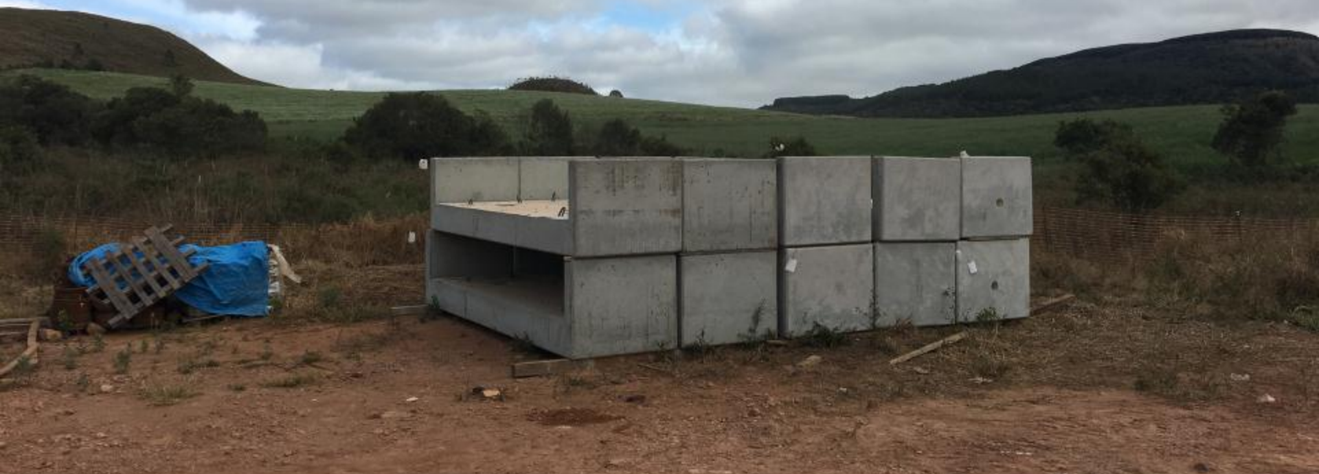
PONTE PRÉ-FABRICADA RECEBIDO PARTE DAS PEÇAS DO TABULEIRO DA PONTE
