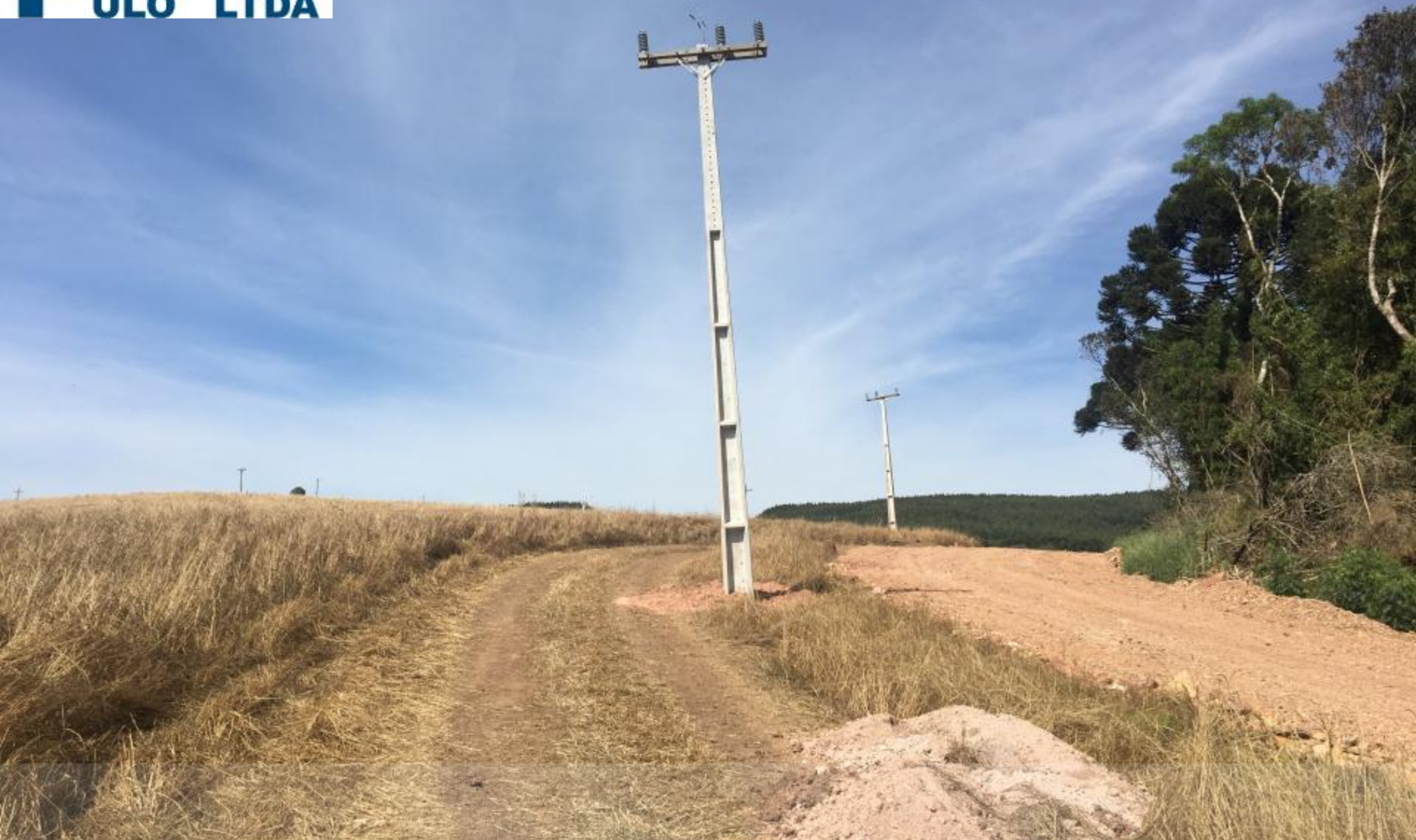
LINHA ENTRE A PCH PULO E A PCH CASTRO EM EXECUÇÃO
