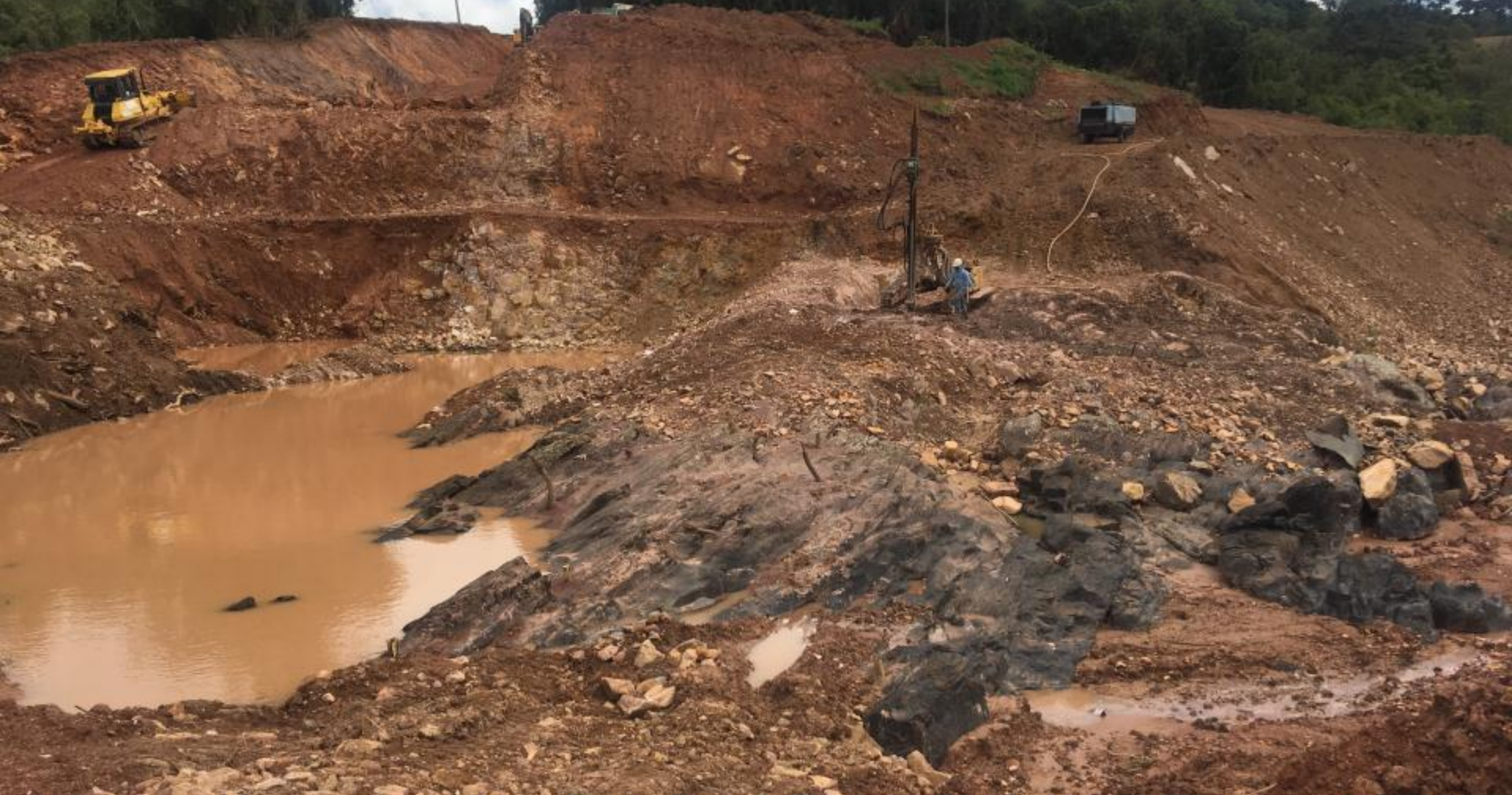
BARRAGEM VISTA DA OMBREIRA ESQUERDA
